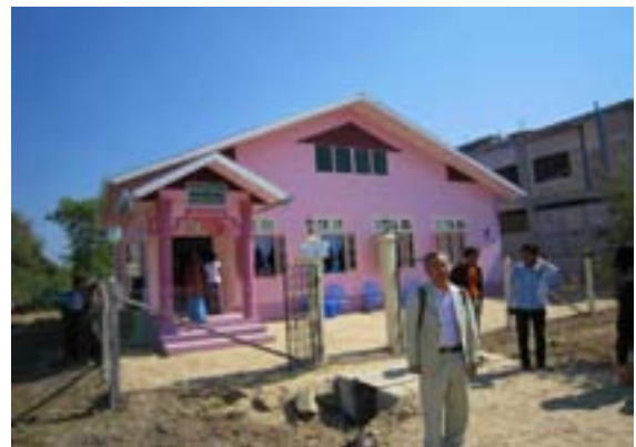
診療所の全景 玄関には[KIBOHクリニック]と掲示
