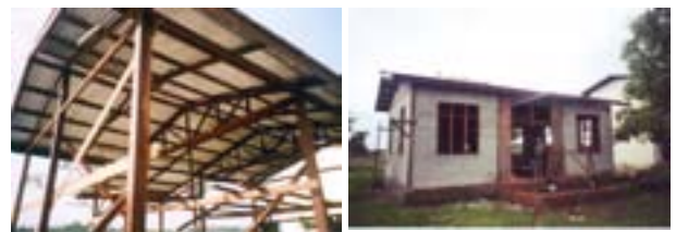
建築中の図書館
