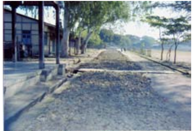
写真上：採石を敷き詰め 写真中・下：舗装工事完了後
